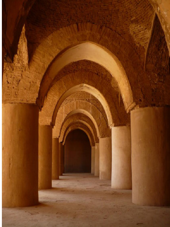
تصویر ۲-۱۴: بخشی از شبستان جنوبی مسجد ( http://www.panoramio.com )
